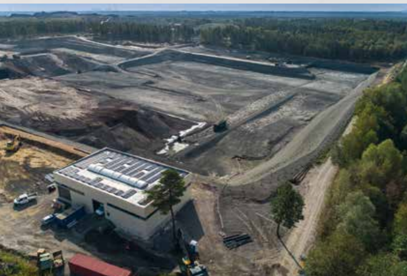
Im Gebäude befindet sich die im Bau befindliche Sickerwasseraufbereitungsanlage. Im Hintergrund das Speicherbecken für das anfallende Sickerwasser. Foto: Privat
